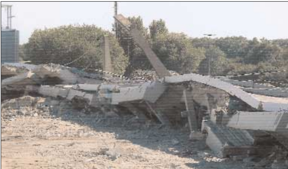
Bild 7: Sprengergebnis, Foto: Michael Dammer
