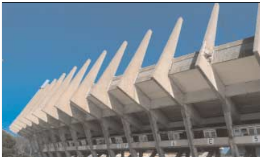
Bild 2: Das Stadion vor der Sprengung, Foto: Michael Dammer
